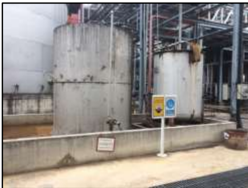
รูปที่ 2-39 ถังเก็บ NaOH
