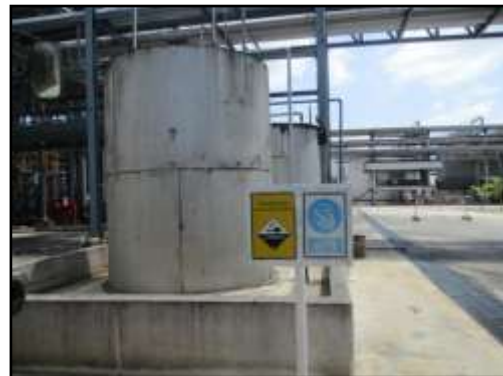
รูปที่ 2-39 ถังเก็บ NaOH
