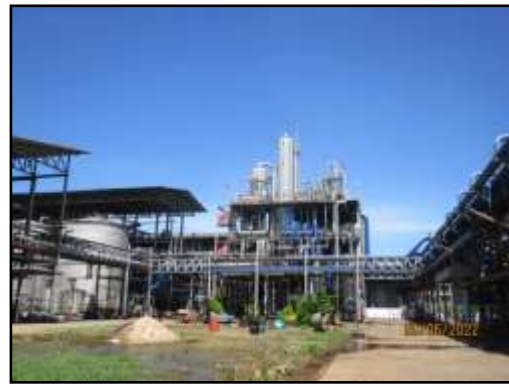
รูปที่ 2-9 ถังหมัก หอกั่น และหอกลั่นน้ำที่เป็นระบบปิด
