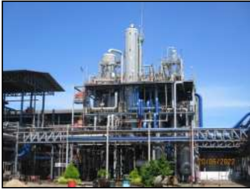
รูปที่ 2-9 ถังหมัก หอกั่น และหอกลั่นน้ำที่เป็นระบบปิด
