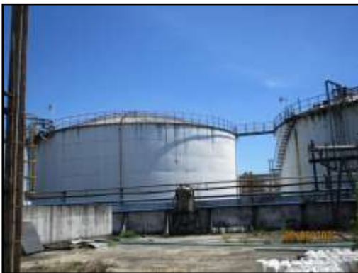
รูปที่ 2-34 ถังคอนกรีตล้อมรอบถังเก็บเอทานอล
