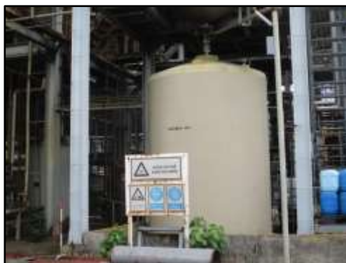
รูปที่ 2-39 ถังเก็บ NaOH
