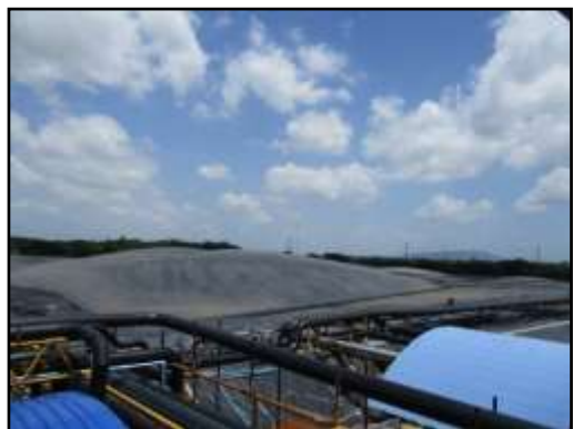
รูปที่ 2-4 พลาสติก HDPE ปิดคลุมบ่อกักน้ำเสียของโครงการ
