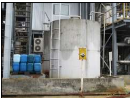
รูปที่ 2-40 ถังเก็บ H_2SO_4
